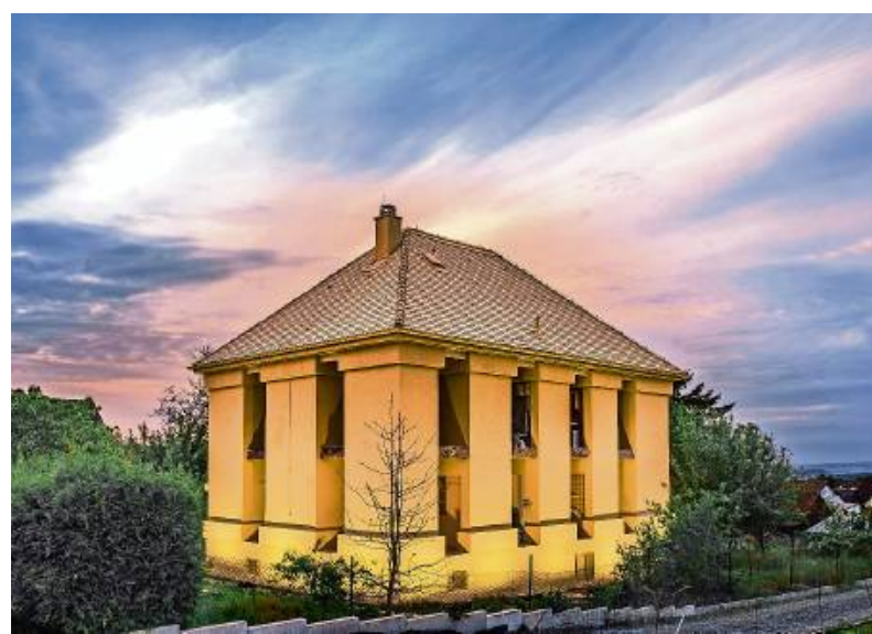
Umgestaltet: Auf zwölf Säulen ruht das große Walmdach. Die Öffnungen bieten interessante Einblicke in das Innere des Gebäudes.
