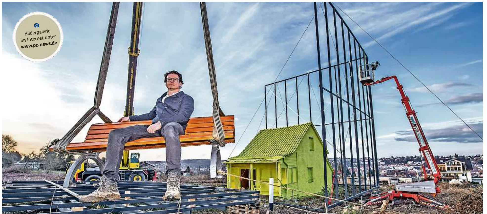
Eine sichere Bank? Andreas Sarow, am Kran hängend, vor seinem neuen Kunstprojekt „Das bedrohte Haus“. Die Fertigstellung verzögerte sich wegen des Wetters, heute soll die Skulptur komplett sein. FOTO: MEYER
